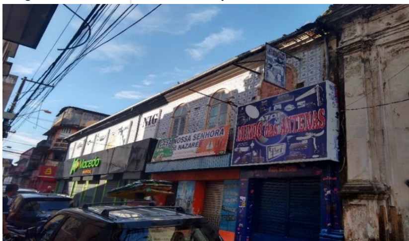
Figura 4 – Sobrados anexos a Capela Pombo descaracterizados.
